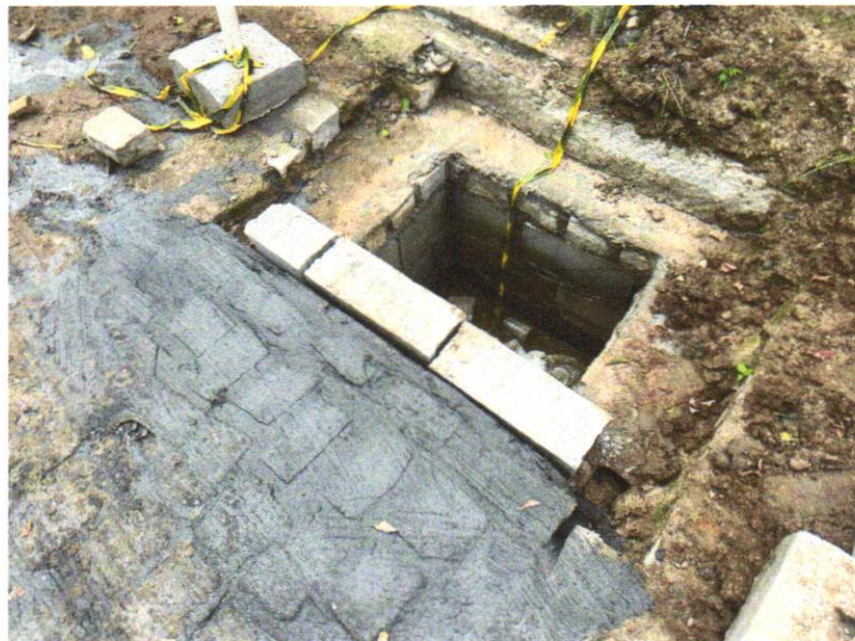
Foto 10 - ALVENARIA DE BLOCOS DE CONCRETO ESTRUTURAL 14X19X39 CM, (ESPESSURA 14 CM) FBK = 14,0 MPA, PARA PAREDES COM ÁREA LÍQUIDA MENOR QUE 6M 2 , SEM VÃOS, UTILIZANDO PALHETA. AF_12/2014
