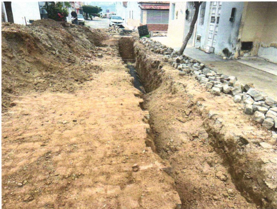
Foto 07 - ATERRO MANUAL COM SOLO ARGILO-ARENOSO IMPORTADO E COMPACTAÇÃO MECANIZADA EM CAMADAS DE 0,20 M NO MÁXIMO
