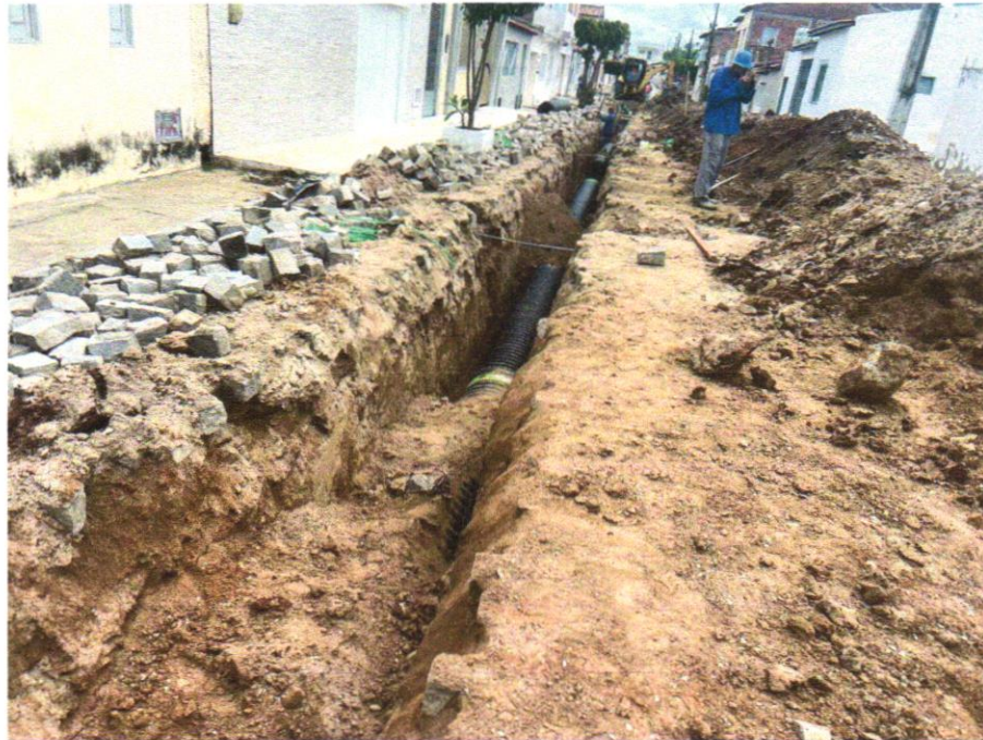
Foto 13 - FORNECIMENTO E ASSENTAMENTO DE TUBO CORRUGADO PAREDE DUPLA PEAD, D = 600 MM (24"), PARA SISTEMAS DRENAGEM, TIGRE - ADS N-12
