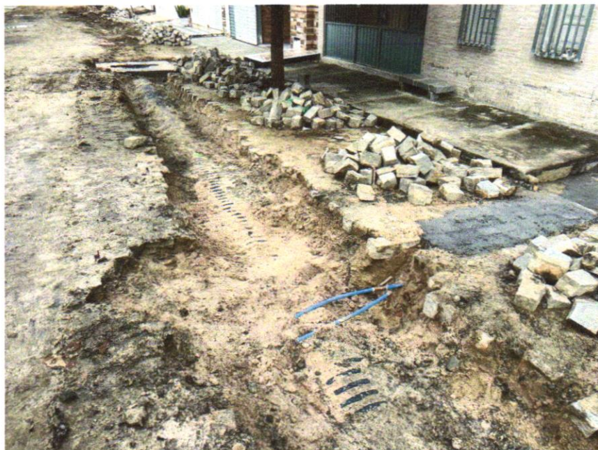
Foto 08 - ATERRO MANUAL COM SOLO ARGILO-ARENOSO IMPORTADO E COMPACTAÇÃO MECANIZADA EM CAMADAS DE 0,20 M NO MÁXIMO
