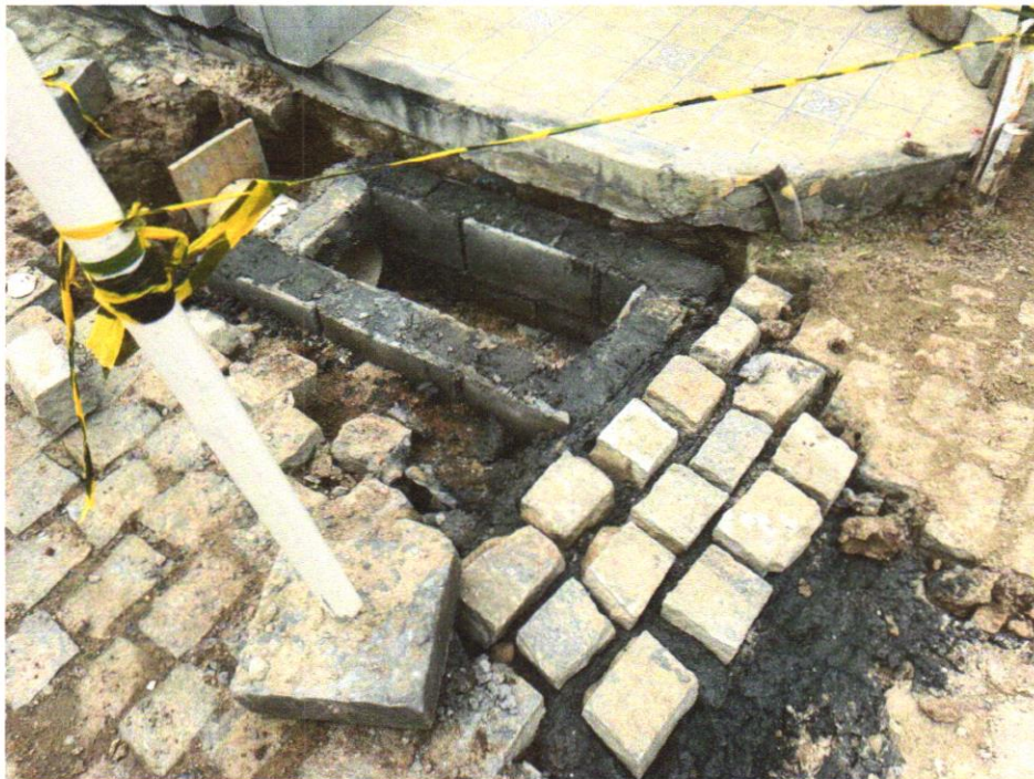
Foto 09 - ALVENARIA DE VEDAÇÃO DE BLOCOS VAZADOS DE CONCRETO DE 9X19X39CM (ESPESSURA 9CM) DE PAREDES COM ÁREA LÍQUIDA MAIOR OU IGUAL A 6M 2 COM VÃOS E ARGAMASSA DE ASSENTAMENTO COM PREPARO MANUAL. AF_06/2014
